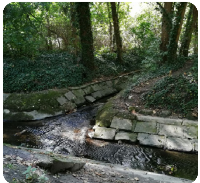
4. kép: A Rákospatak gödöllői szakaszán mellékág becsatlakozása
