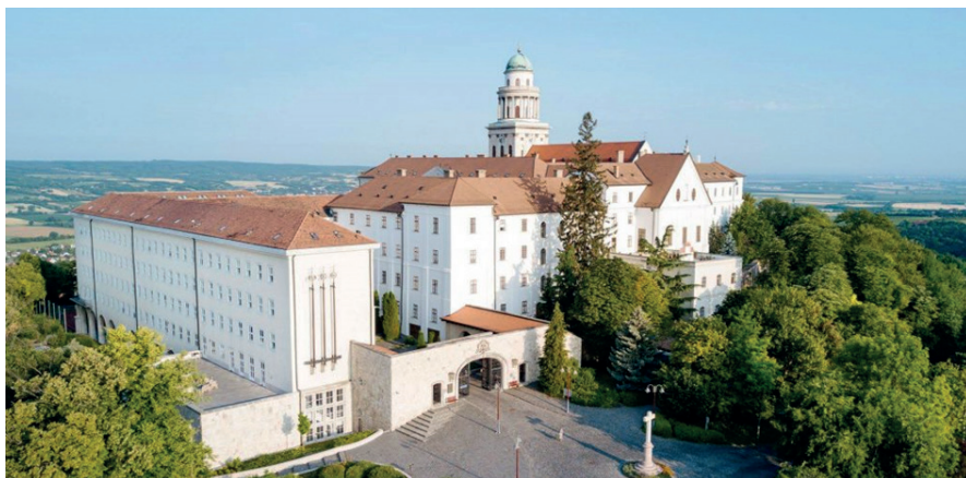
3. ábra A Pannonthalmi Főapátság
