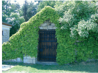
6. fotó Tolcsvai pince homlokzat
